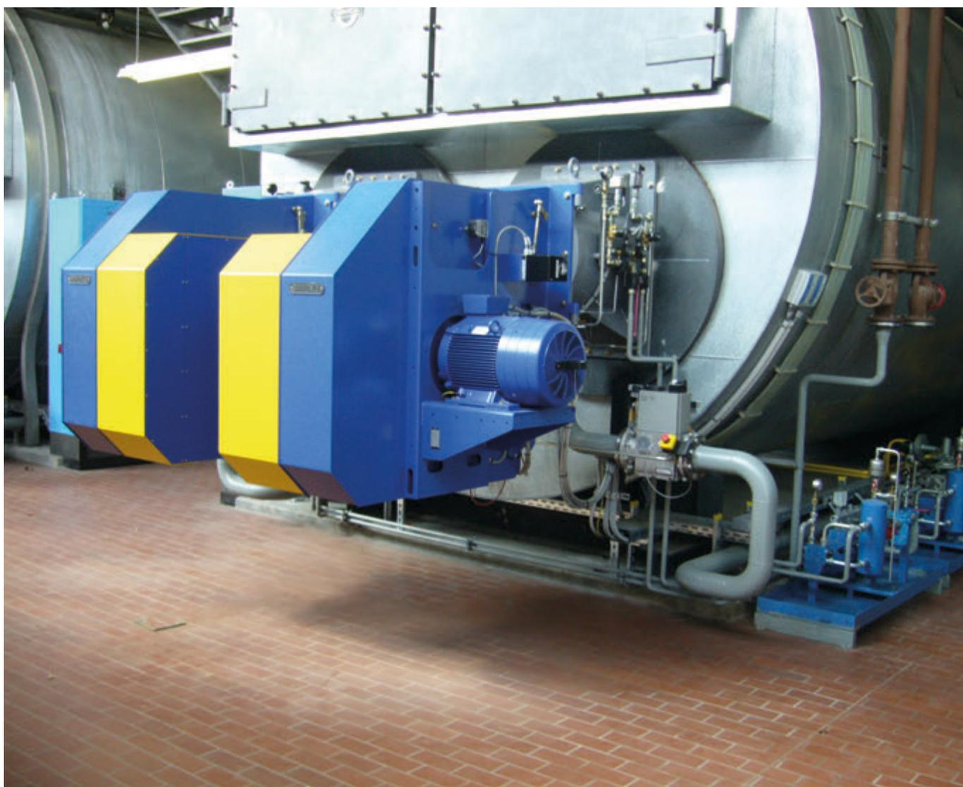
Brenner TEMINOX der Firma Saacke mit hp-Einzelaggregat der Baureihe MOG 1900
